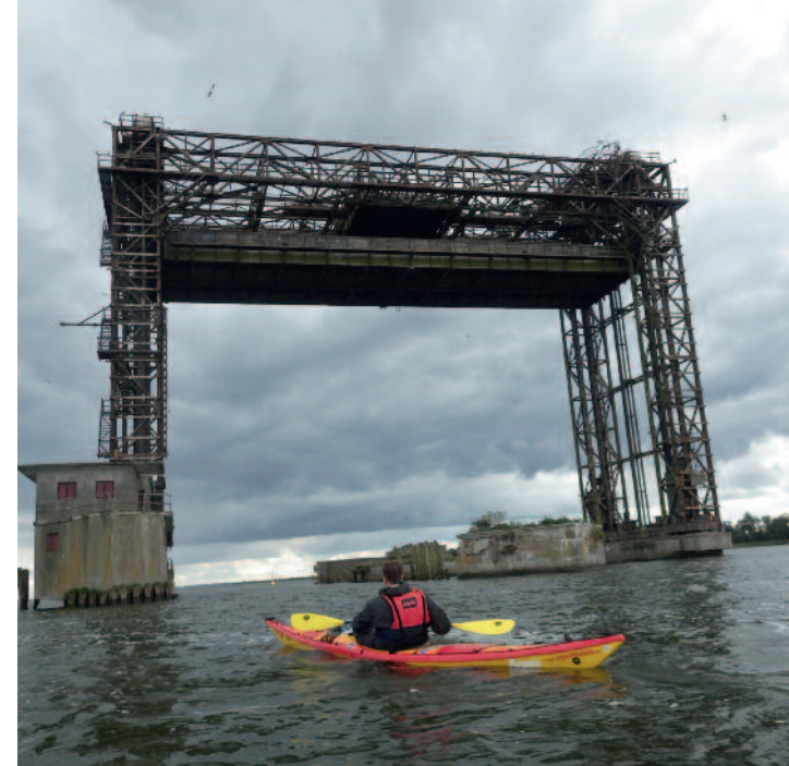
Eisenbahnhubbrücke bei Karnin.
